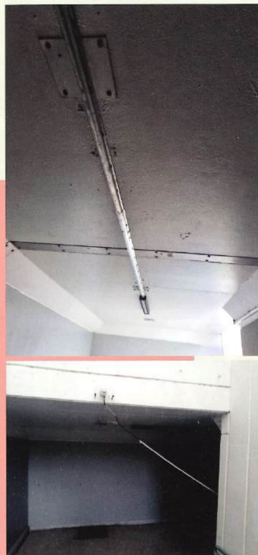
Réparation des dégradations dans le souterrain.
